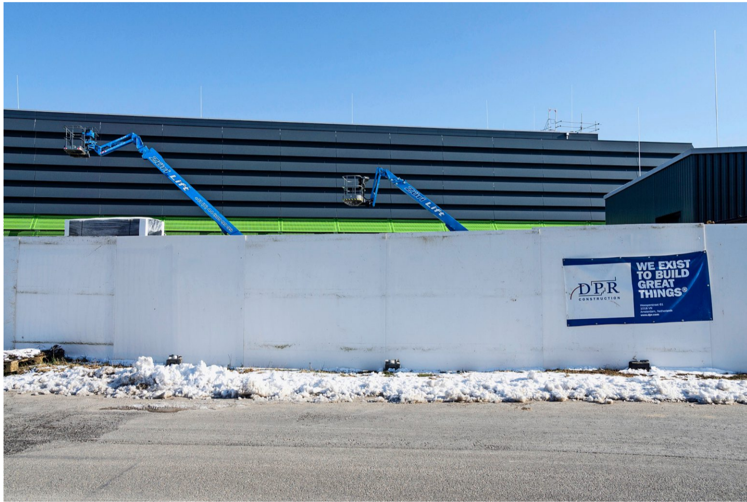
Bald wird dieses Rechenzentrum in Rafz eröffnet. Wessen Server darin arbeiten werden, weiss man nicht. Foto: Andrea Zahler
